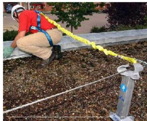
شکل ۵۴-۲ محدود کننده با اتصال یک طناب
