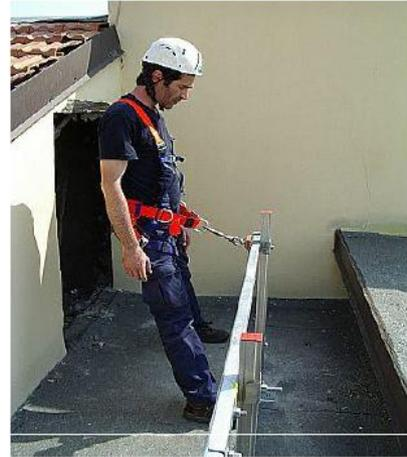
شکل ۴-۵۴ محدودکننده با اتصال یک ریل مخصوص
