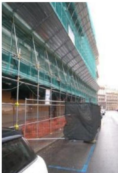
کلیه قسمت‌های داربست (جایگاه، اجزای نگه‌دارنده، تکیه‌گاه‌ها، اتصالات، راه‌های عبور و پلکان داربست) باید با استفاده از مصالح مناسب و مرغوب مانند چوب، فولاد و امثال آن توسط شخص ذیصلاح طوری طراحی، ساخته و آماده به کار شود که داربست علاوه بر ایستایی و پایداری لازم، ظرفیت پذیرش چهار برابر بار مورد نظر را داشته باشد.
