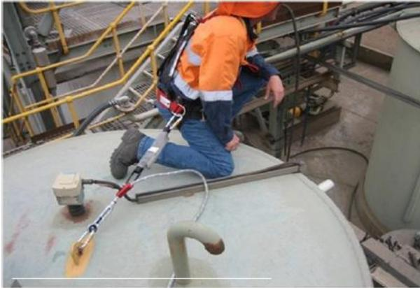
شکل ۳-۵۴ محدودکننده با اتصال یک نقطه
