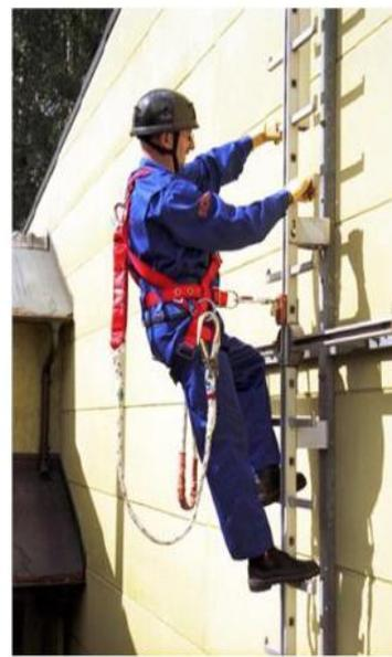
شکل ۱۱۰- سامانه متوقف کننده یا استفاده از ریل مخصوص در نردبان
