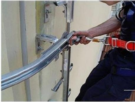
اشکال ۱۱۱- سامانه محدودکننده با استفاده از ریل
